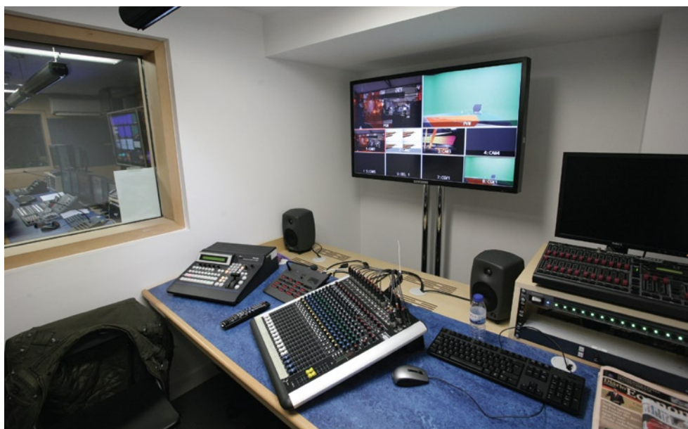
O Económico TV dispõe ainda de uma segunda régie de produção mais simples, equipada com uma mesa de mistura Panasonic AV-HS400A com multiviewer integrado
