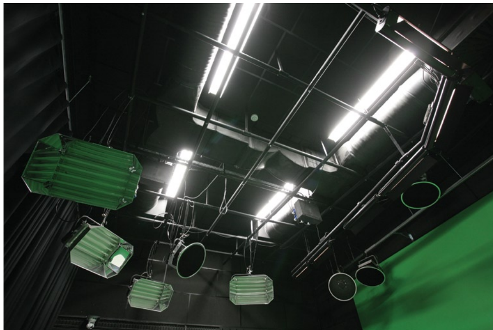
Pormenores das racks de distribuição de sinais dos estúdios e teia de iluminação do Estúdio B, com iluminação fluorescente da Balcar. Dois aspectos que demonstram a qualidade do trabalho efectuado pelas empresas sub-contratadas, a RED do grupo Ibertelco e a empresa de Paulo Padrão, respectivamente
